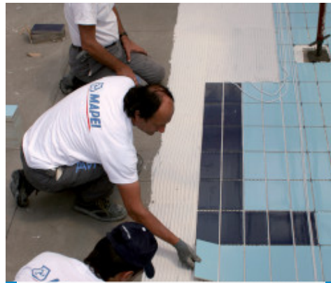
Aanbrengen van keramische tegels op Mapelastix Zero in een zwembad
