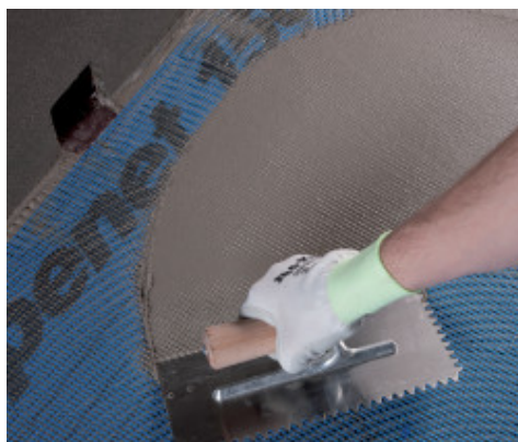
Aanbrengen van Mapelastic Zero op Mapenet 150
