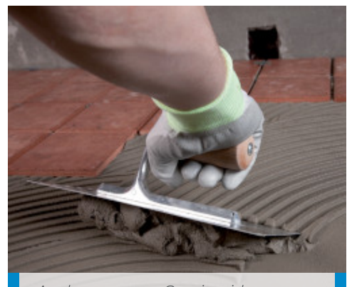
Aanbrengen van Granirapid op een terras dat waterdicht is gemaakt met Mapelastic Zero
