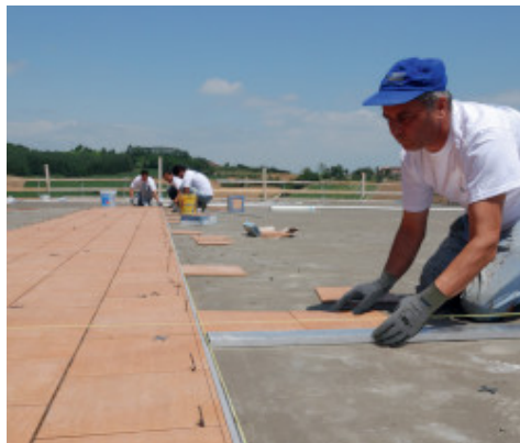
Aanbrengen van keramiek met Kerabond + Isolastic
