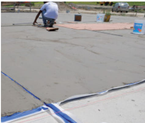
Waterdicht maken van dekvloeren met Mapelastic Zero en Mapeband
