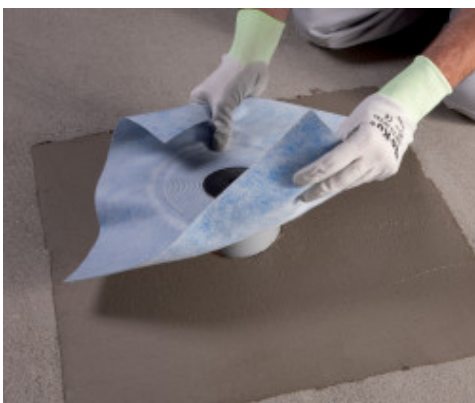
Aanbrengen van een verticale afvoer op Mapelastic Zero
