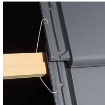
Die Fixierungskerben für die Sturmklammern.
